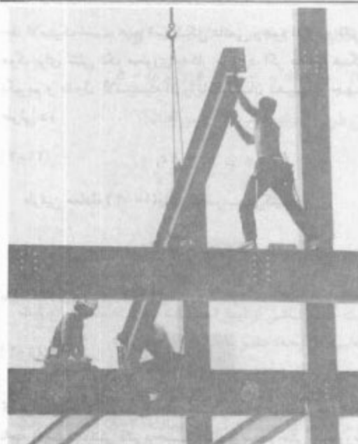
شکل ۱۵-۴ تیرهای فولادی، بال پهن، قاب اغلب ساختمان‌ها را تشکیل می‌دهد.
