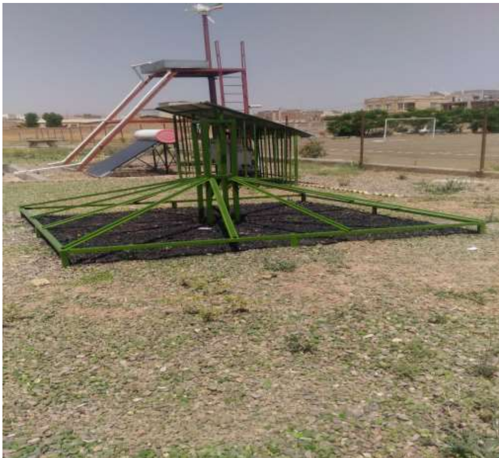
شکل (۵-۶) نصب و رنگ شده اسکلت کلکتور
