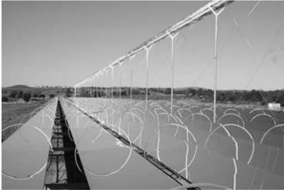
شکل (۹-۱) نیروگاه خورشیدی با سیستم دریافت کننده خطی فرسنگ [۲۰]
