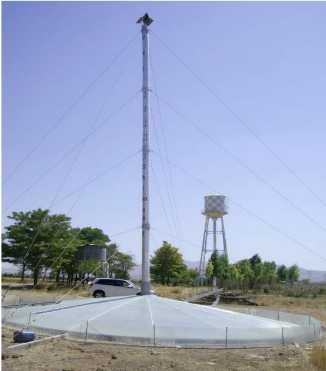
شکل (۲-۸) نمونه ساخته شده نیروگاه دودکش خورشیدی زنجان [۳۹]
