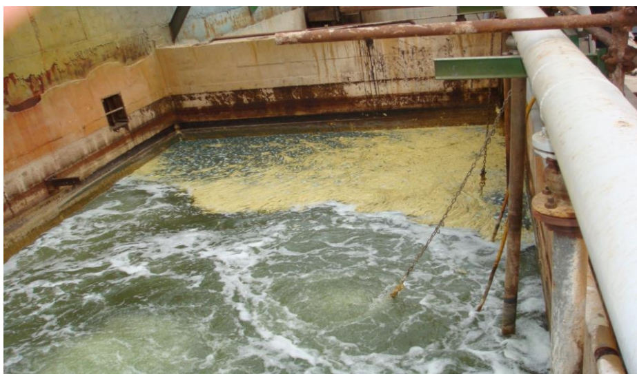
شکل ۳-۲- نمایی از پوند پساب روغنی و وجود پلیمرهای برج کاستیک
