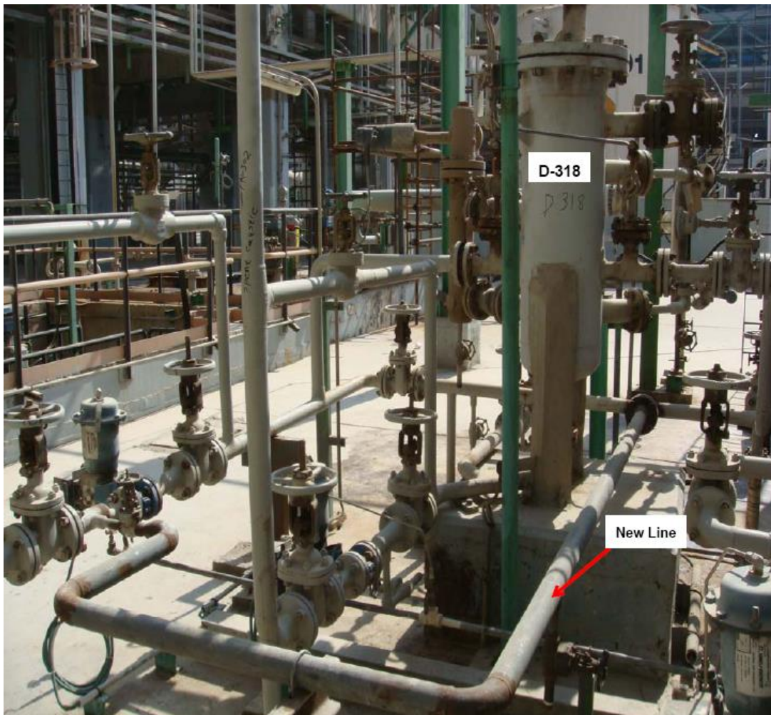
شکل ۳-۹- نمایی از مسیر جدید جهت ارسال بنزین به سمت مخزن Light Slope
