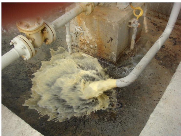
شکل ۴-۵- تخلیه مواد هیدروکربنی از بالای فیلتر ۳۰۲-D بعد از اجرای خط جدید تانک ذخیره کاستیک مصرفی
