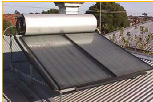
شکل (۳-۵): آبگرمکن ترموسیفون با کالکتور تخت
