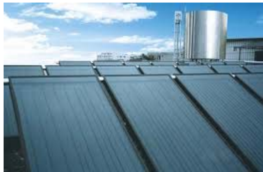
شکل (۳-۴): کالکتور صفحه ای صاف (Flat plat collector)
