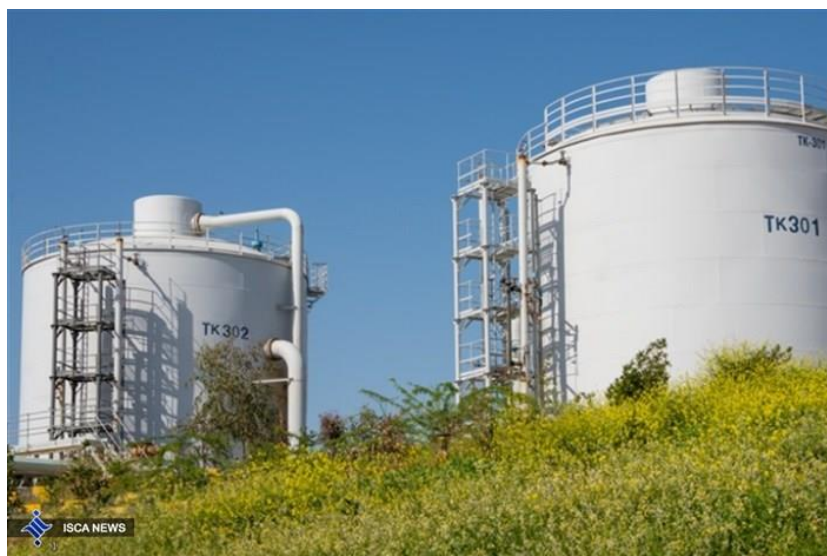
شکل (۳-۲) - مخازن گاززدا در واحد نمک زدایی گچساران ۳ (۳۷)
