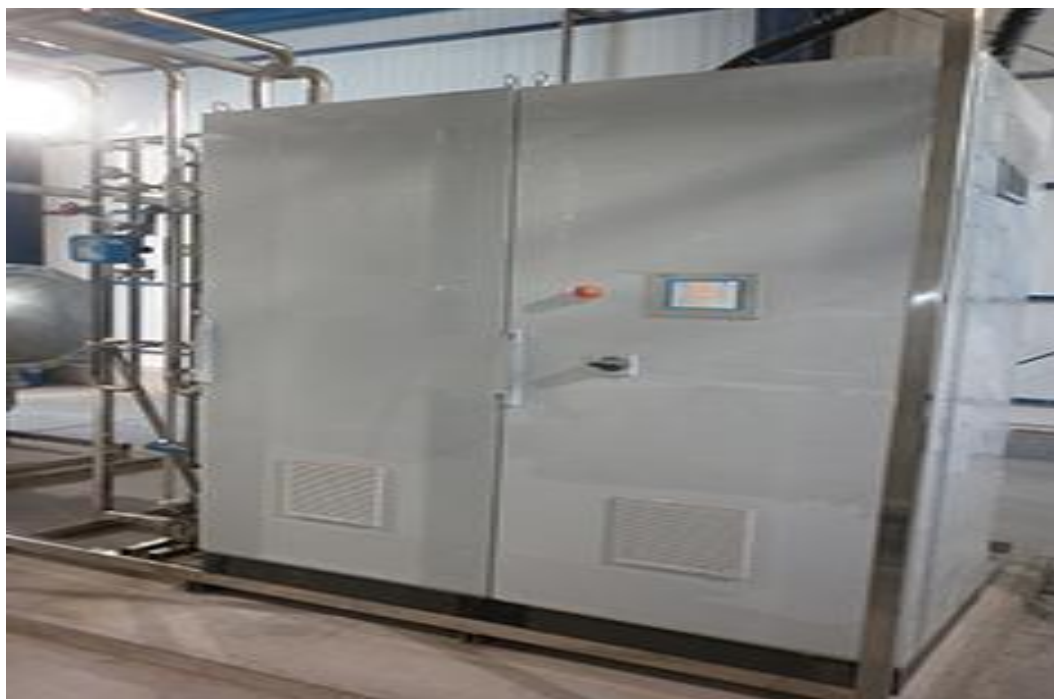
شکل (۳-۶): تابلو برق سیستم ازن زنی (۱۹)
