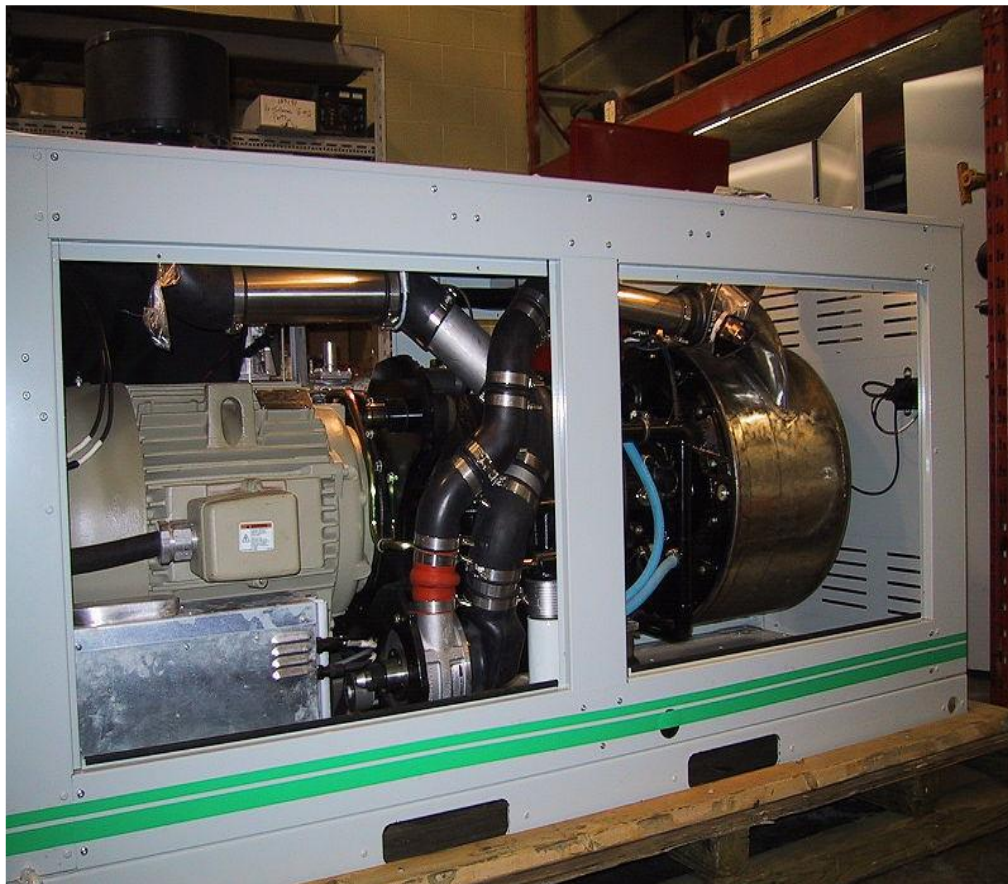
شکل (۱۲-۱) پکیج CHP صنعتی ۵۵ کیلووات مجهز به موتور استرلینگ
