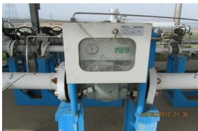
شکل (۸-۳) شیر قطع کن فشار (نگارنده)
