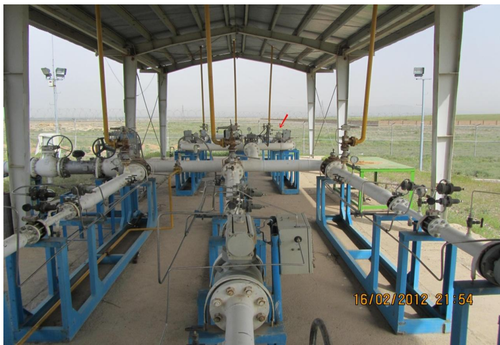
شکل (۳-۲) نمایی از یک ایستگاه تقلیل فشار (نگارنده)
