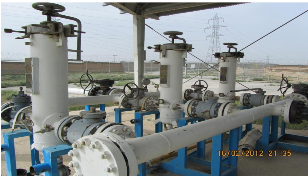
شکل (۳-۳) فیلترهای تصفیه کننده (نگارنده)
