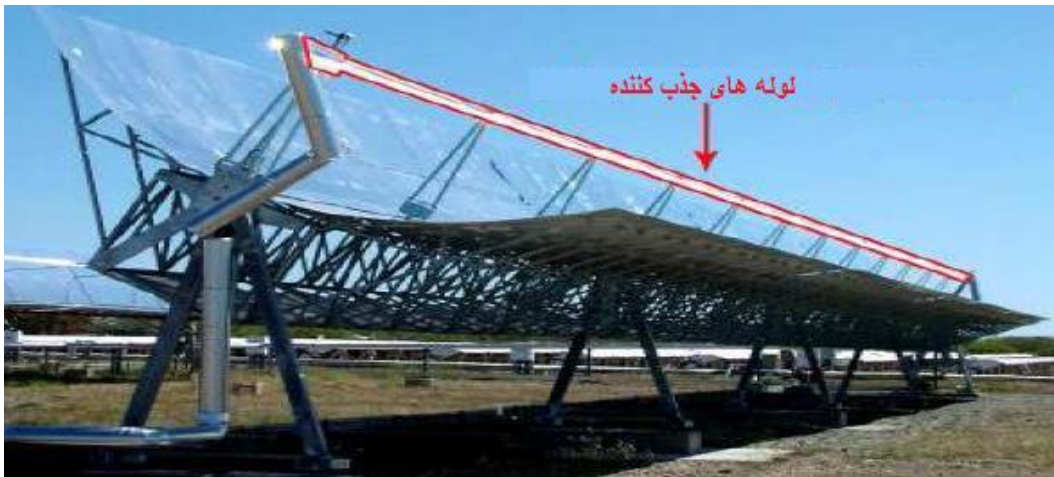
شکل (۲-۱۰) نمایی از بخش جذب کننده کلکتورهای سهموی (Kalogirou,s,2009)
