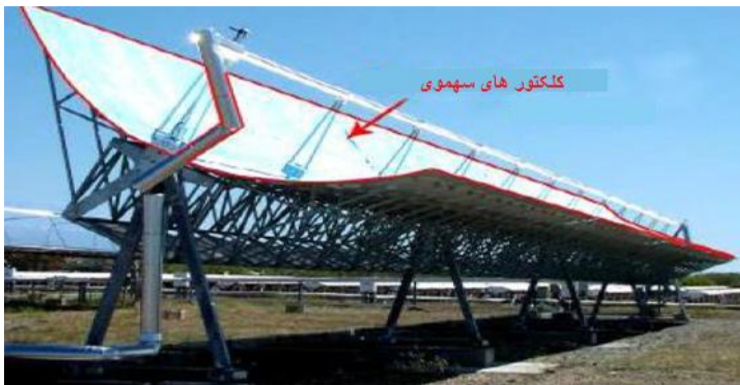
شکل (۲-۹) نمایی از بخش متمرکز کننده کلکتورهای سهموی (Kalogirou,s,2009)
