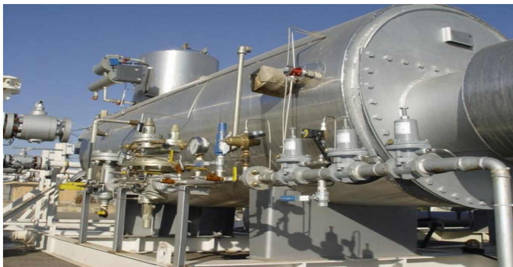
شکل (۳-۱۴) تجهیزات نصب شده روی هیتر (نگارنده)
