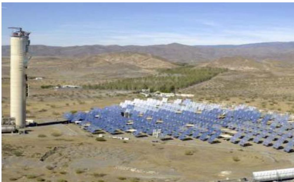
شکل (۲-۱۴) نمایی از آینه‌های منعکس کننده و برج دریافت کننده (Kalogirou, s, 2009)
