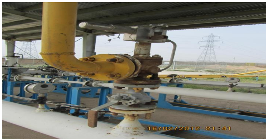
شکل (۷-۳) شیر اطمینان موجود در ایستگاه (نگارنده)
