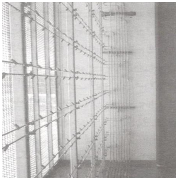
شکل ۶-۲ چیدمان یکنواخت نازل های فاگ درون اتاق فیلتر
