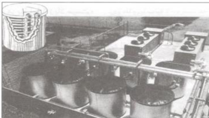
شکل ۲-۱۰ نمونه تانک های یخ مورد استفاده در سیستم ذخیره سازی سرما
