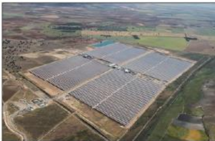
شکل (۱-۶): نیروگاه خورشیدی سهموی خطی سولابن در اسپانیا با ظرفیت ۲۰۰ مگاوات (۳)
