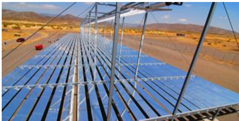
شکل (۱-۱۶): نیروگاه‌های خورشیدی با استفاده از کلکتورهای فرنل (۵)
