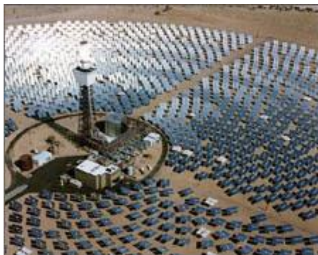
شکل (۱-۹): نیروگاه های خورشیدی با استفاده از دریافت کننده مرکزی (۵)
