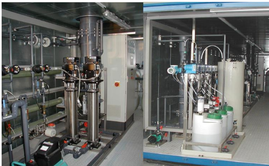
شکل ۲-۲- تصویر پایلوت اسمز معکوس طرح نترات زدایی آب شرب گلشهر مشهد (۱۱۷)
