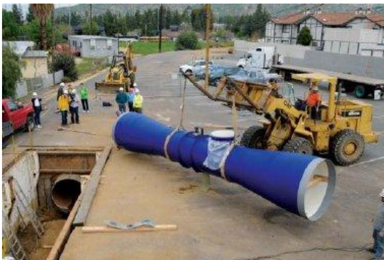
شکل ۳-۵ نصب لوله حاوی هیدروکویل (۳۱)
