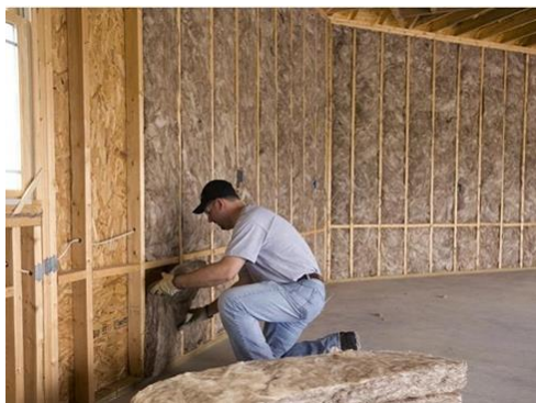
شکل (2-10): بکارگیری عایق پشم معدنی، (51)
