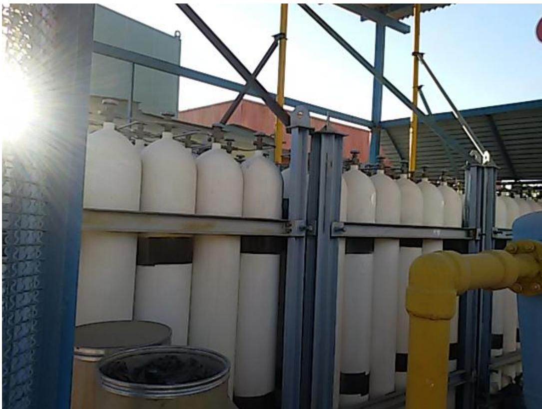
شکل ۱۰-۲ نمونه ای از بانک مخازن نصب شده در جایگاه CNG
