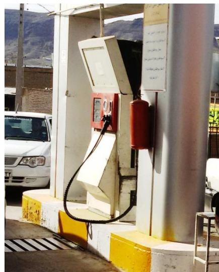
شکل (۴-۱) نمونه خاموش کننده های منصوبه در جایگاه جهت مبارزه با حریق احتمالی
