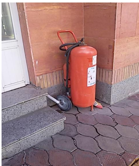
شکل (۴-۱) نمونه خاموش کننده های منصوبه در جایگاه جهت مبارزه با حریق احتمالی
