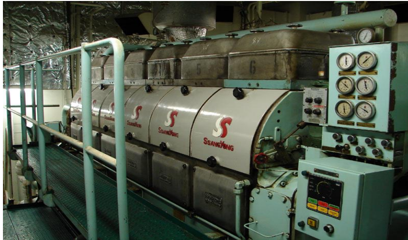
شکل (۱-۲): تصویری از یک دیزل ژنراتور [۲۱].
