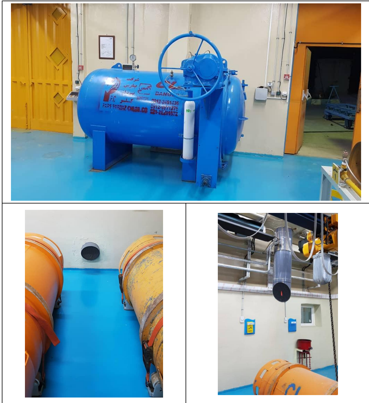
شکل (۷-۵) سیستم خنثی ساز / Scrubber در سالن نگهداری سیلندرهای تحت فشار ماده سمی کلر
