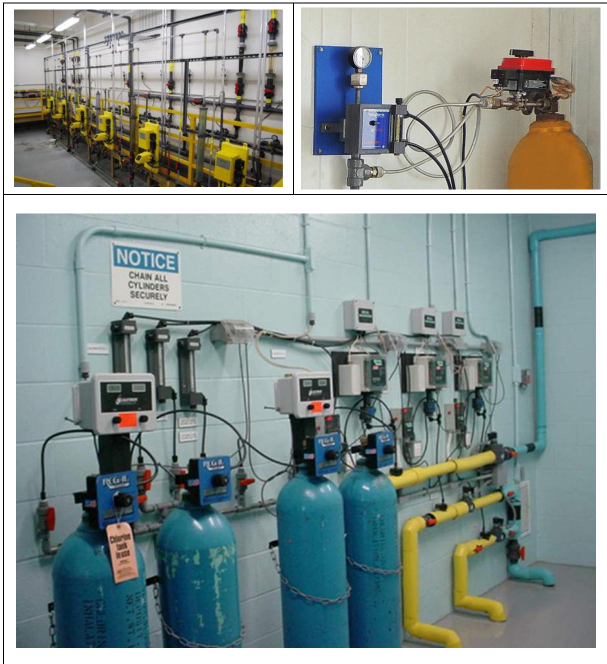
شکل (۳-۴) سیستم کلر زنی گاز کلر در تصفیه خانه فاضلاب
