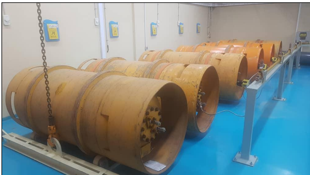
شکل (۳-۷) سیلندرهایی ۱ تنی تحت فشار مایع و گاز سمی کلر در اتاق کلرزنی تصفیه خانه فاضلاب ۲ کن
