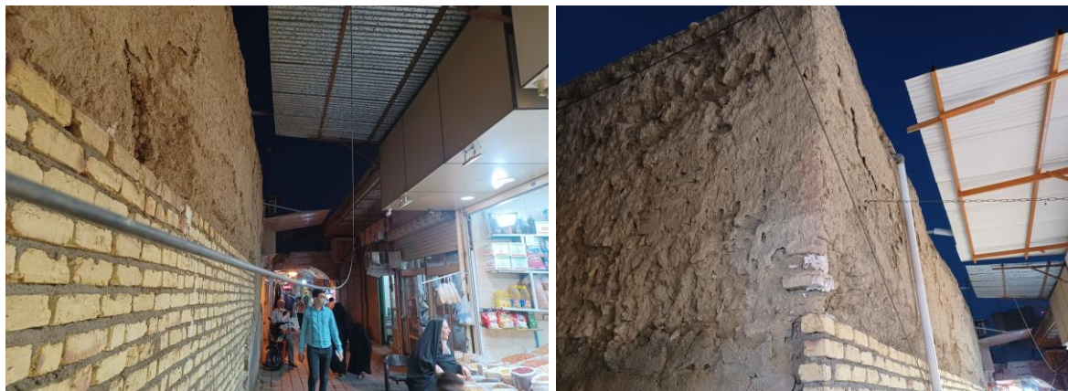
شکل ۴-۶- خطر ریزش بافت فرسوده
