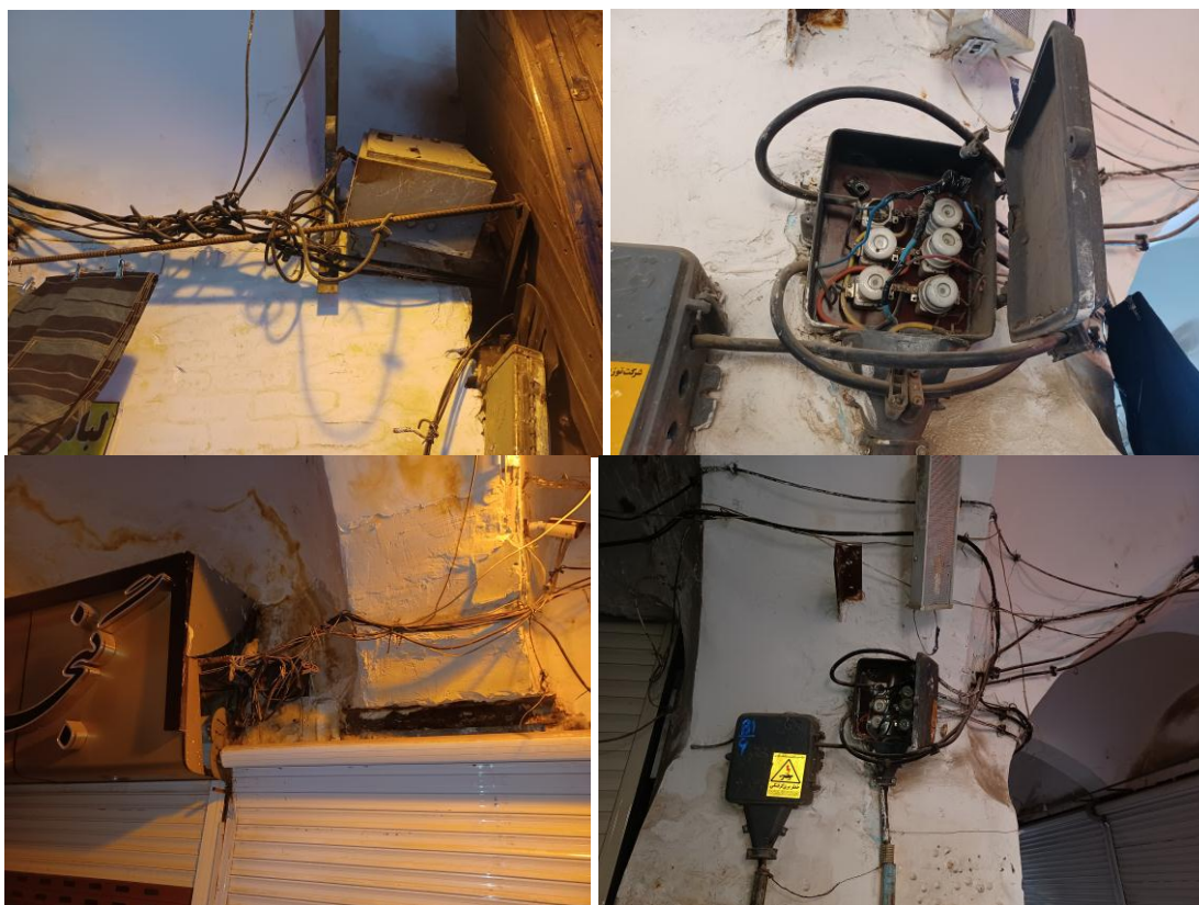
شکل ۴-۱- وضعیت سیستم برق‌رسانی و سیم‌کشی در بازار شهر ساوه
