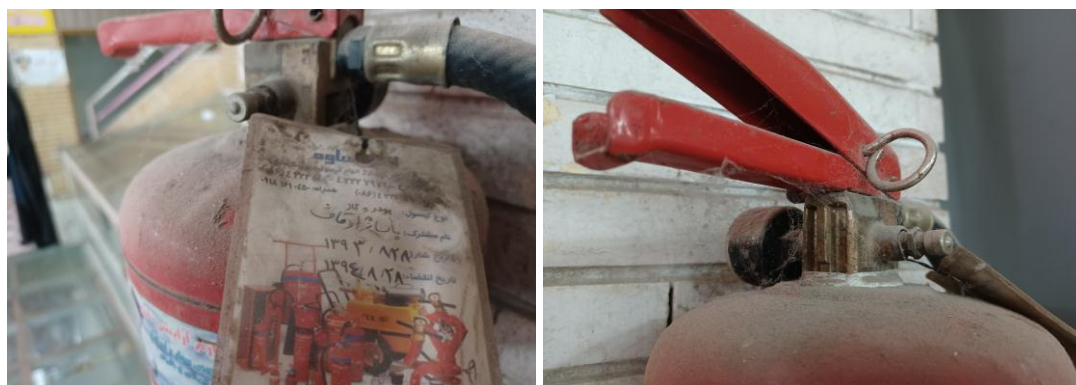
شکل ۴-۳- بی تفاوت بودن کسبه به کپسول اطفای حریق و عدم شارژ سالیانه آن
