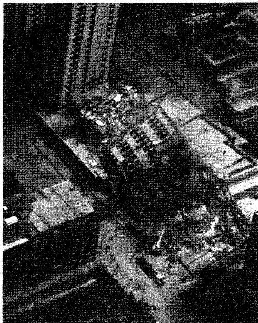
شکل ۱۸-۳۱ در سال ۱۹۸۵/۱۳۶۴ ساختمانهای نیمه‌بلند در شهر مکزیکو بر اثر زمین‌لرزه‌ای که در فاصله دور از شهر رخ داده، تخریب شدند. ساختمانهای بلندتر و کوتاه‌تر تخریب نشدند.
