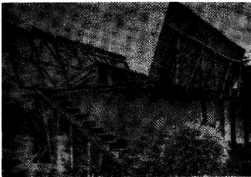
شکل ۱۳-۱: انبار خشک کن خورشیدی، سقف انبار برای تابش مستقیم خورشید در هنگام روز باز می شود
