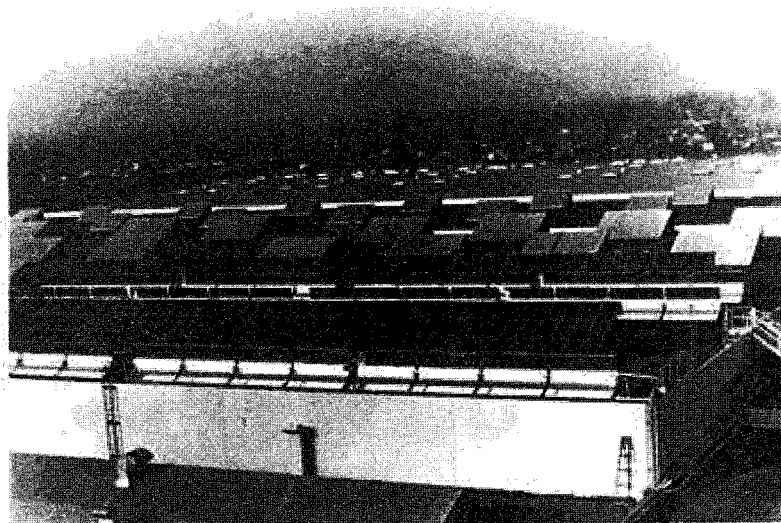
شکل ۶-۲: گردآورهای مسطح بعنوان پیش گرمکن در پشتمان یک کارخانه مواد غذایی.
