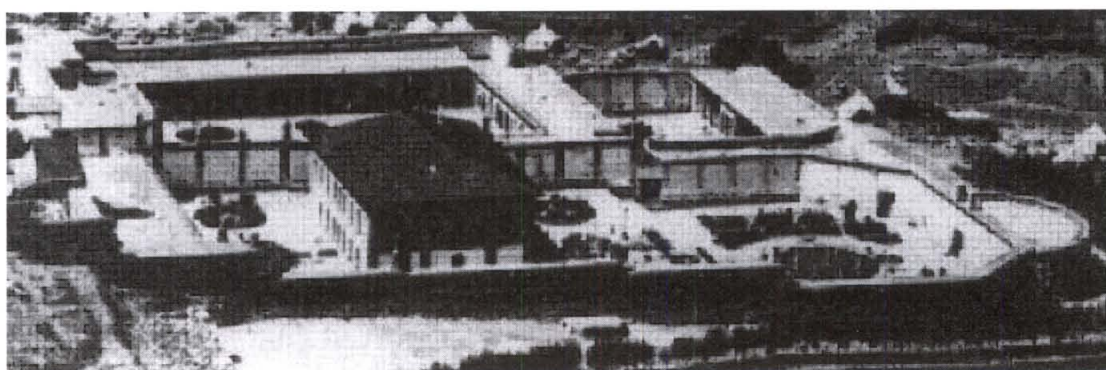
شکل ۸-۱۱: حیاط بیرونی و اندرونی کاخ بیلاقی شهرستانک، قرارگیری این ساختمان در کوهپایه، موجب جریان هوا از سمت ساختمان بطرف تپه در روز و از تپه به طرف ساختمان در شب میگردد، بدین ترتیب همواره نسیم از پنجره‌های موجود در ضلع جنوبی و شمالی ساختمان جریان دارد. جریان آب بصورت نهر و آبنا از داخل ساختمان عبور می نماید.
