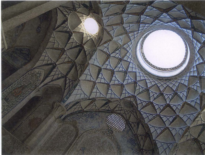
شکل: ۱۰-۱۸- نورگذر افقی در پشتبام برای دریافت نور مستقیم خورشید کمتر از نور گذرهای عمودی در بناهای تاریخی ایران دیده میشود. یکی از علل آن استفاده از روشنایی و حرارت در عین سهولت کنترل آن است. اما بدیهی است که دارای زیبایی بیشتر است.
