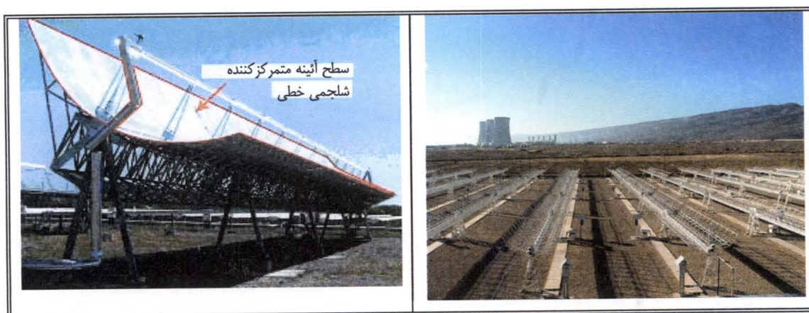
شکل ۱۶-۱۱: نیروگاه خورشیدی از نوع سهموی خطی با قدرت ۲۵۰ کیلو وات الکتریک در مجاورت نیروگاه سیکل ترکیبی شیراز، قبل از نصب آئینه‌ها - یک نمونه گردآور سهموی خطی
