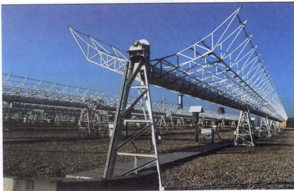
شکل ۹-۱۴: تصویر یک بند تغییرات دما که از چند بند حرکتی تشکیل شده است، متعلق به نیروگاه خورشیدی شیراز.
