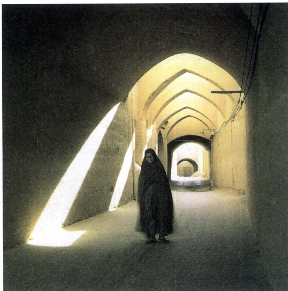
شکل: ۱۱-۱۷: نمونه ای از کوچه های سر پوشیده شهر یزد. در فصل ۴ دیدیم که تابش مستقیم بیش از ۹۰٪ از انرژی رسیده از خورشید به زمین را تشکیل می دهد. بنابراین بدن عابرین در این کوچه ها کمتر از ۱۰٪ حرارت ناشی از تابش پراکنده را دریافت می کنند. بعلاوه سازه خنک سقف و دیوار کوچه، بر اساس سیستم ایجاد موانع خارجی جذب حرارت، انتقال حرارت ناشی از هدایت را نیز به تاخیر می اندازند. با افزایش جرم سازه این تاخیر تا خنک شدن هوا در عصر ادامه می یابد.
