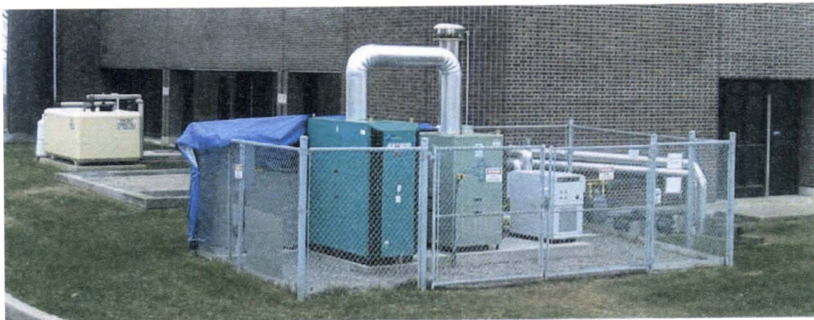
شکل ۱۶-۲۱: میکرو توربین گازی همراه با سیستم بازیاب حرارت و تابلوی برق
