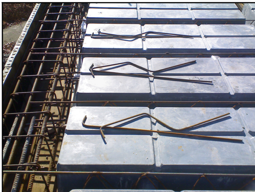
(آرماتور اوتکا یک طرفه در تیر بتنی)
