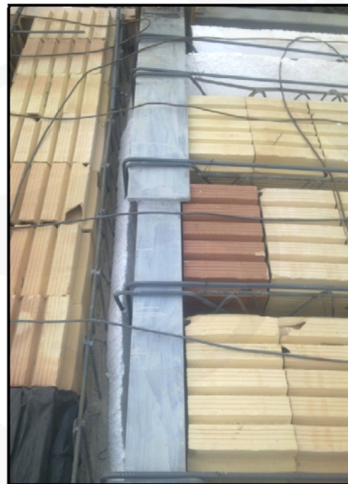
(آرماتور اوتکا یک طرفه در تیر فولادی)
