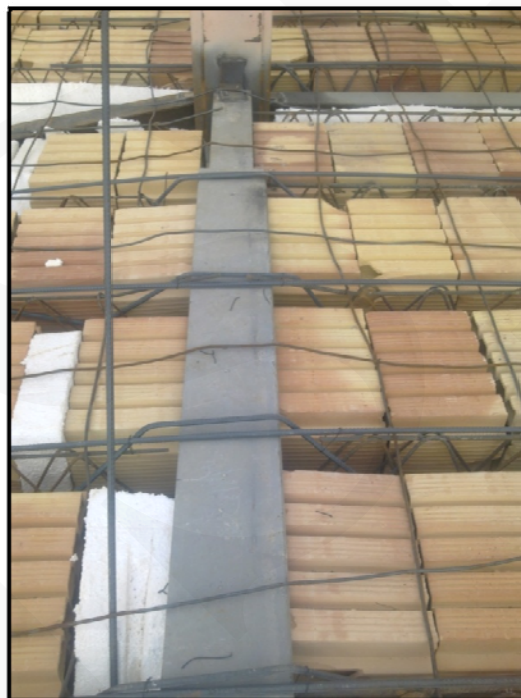
(آرماتور اوتکا دو طرفه در تیر فولادی)
