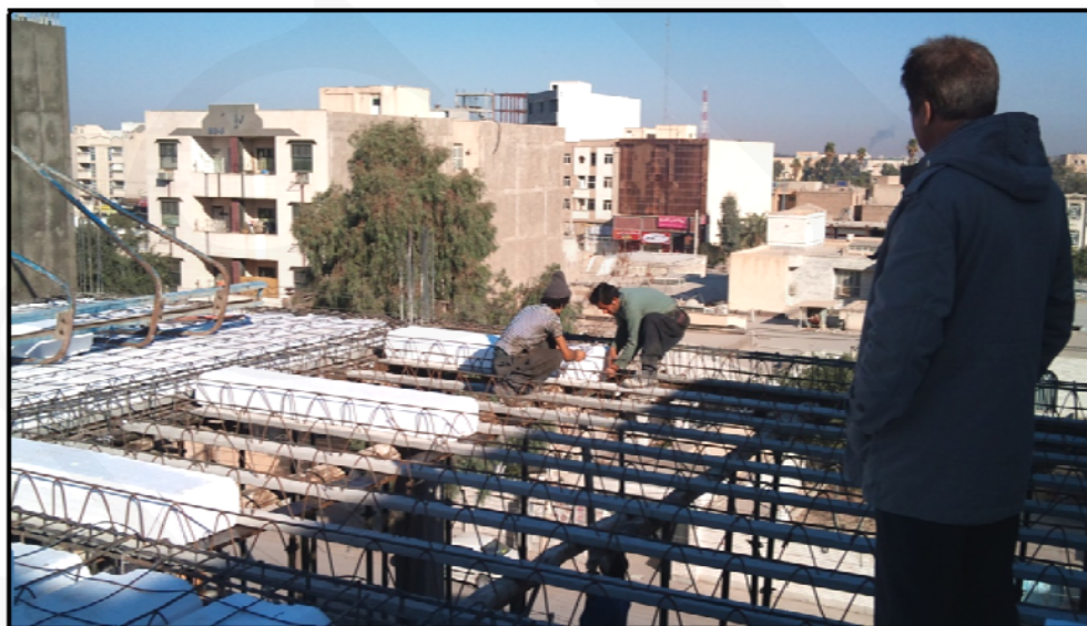
(سقف تیرچه و بلوک با بلوک یونولیتی)
