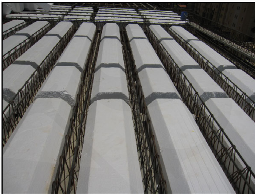
(سقف تیرچه و بلوک با بلوک یونولیتی)
