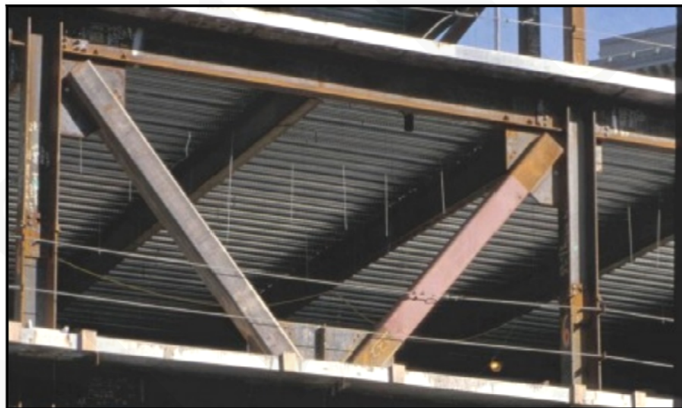
(بادبند ۷ شکل با پروفیل ناودانی)
