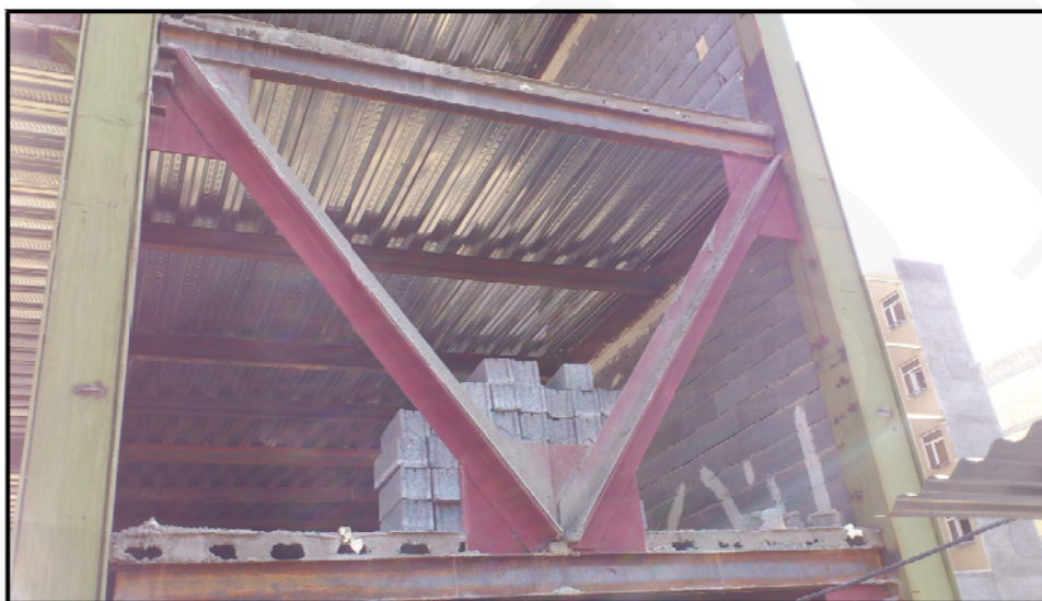
(بادبند ۷ شکل با پروفیل نبشی)
