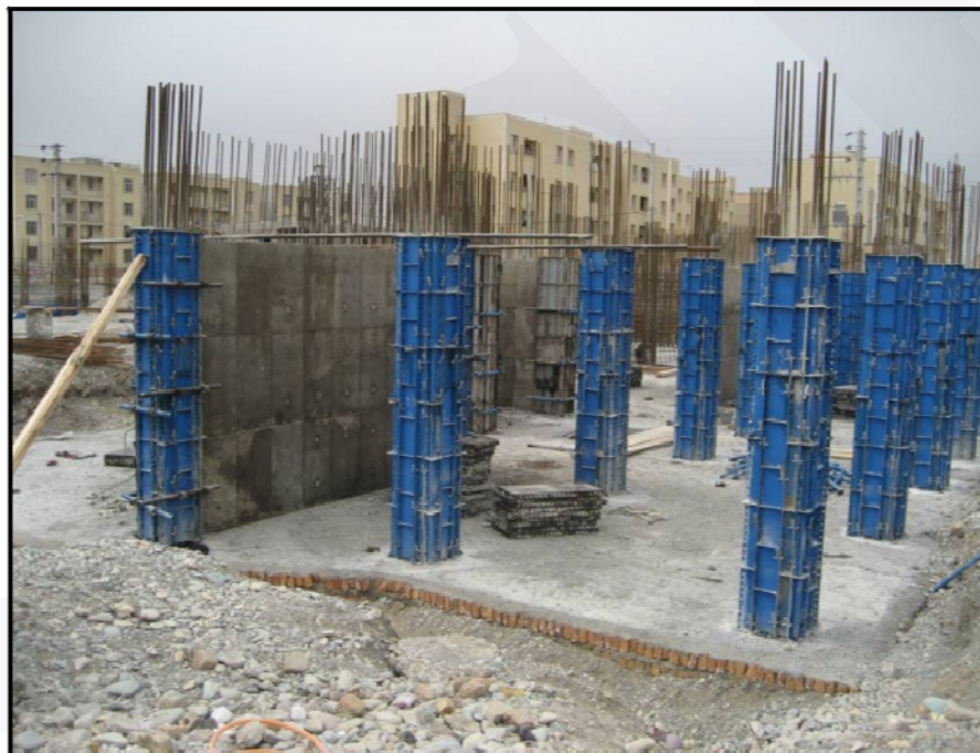
(قالب بندی ستون و دیوار برشی)
